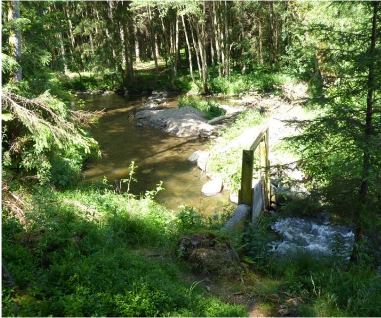
Abbildung 3: Steinwurfwehr mit Ausleitungsstelle (Foto: IB Pfeffer)
